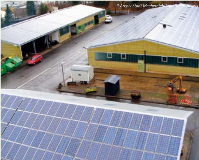
Solkollektoren auf den Dächern der Bauhofgebäude
