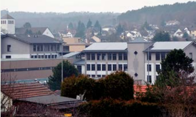
Solarkollektoren auf den Dächern des Schulzentrums in Mechernich
