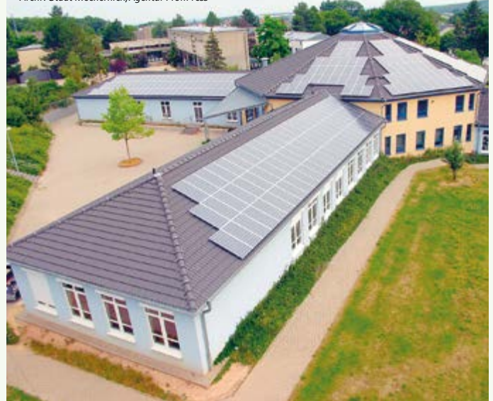
Solarkollektoren auf der Schule in Satzvey
