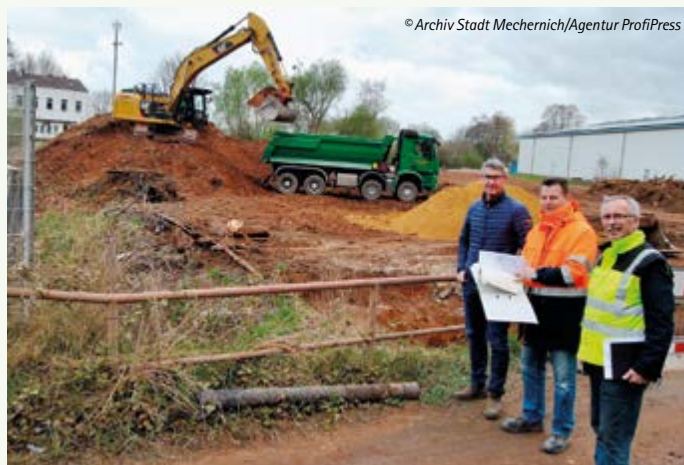
Bauarbeiten „Am Billig Satzvey“
